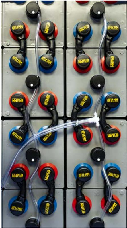
Batteria ad alta capacità - H-capacity battery
